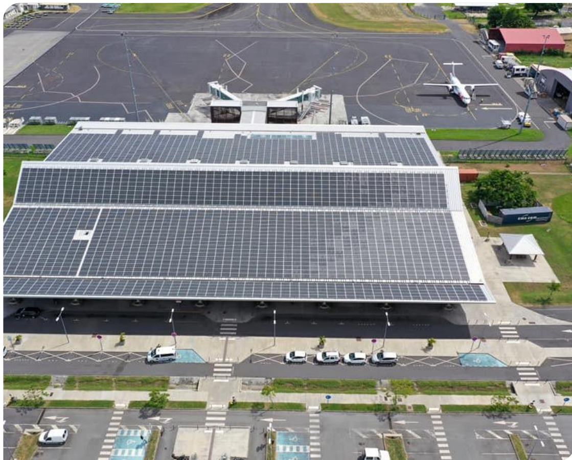
0.9MWp + 0.7MWh baterii na lotnisku Majotta
